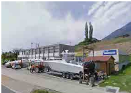
Constructions en zone d'activités artisanales
